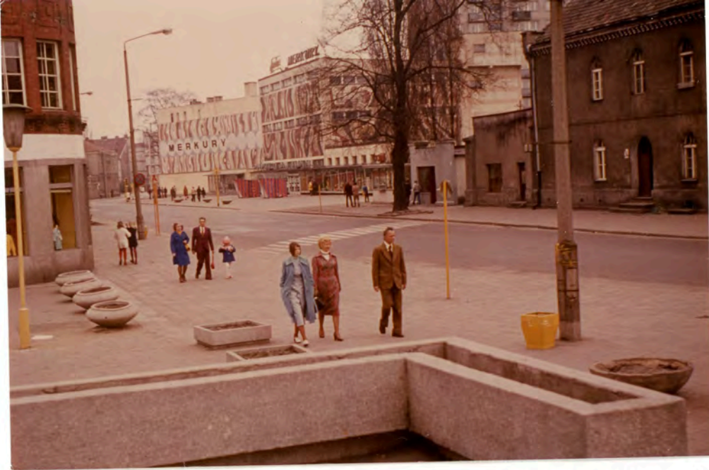
Blick vom Central-Hotel-Standort über den Beginn der Fußgängerzone Posener Straße in die Zeughausstraße. Rechts das alte Zeughaus, das vor 1945 unter Denkmalschutz stand, es ist 1843/1844 erbaut worden. Das untere Bild stammt aus dem Jahre 1993.
